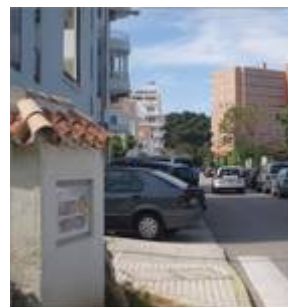
Obras terminadas de la C/ Alberto Morgenstern
